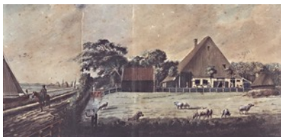
Schagerbrug – Hoop en Vlijt 1 – Eigenaar onbekend – Restauratie nodig
