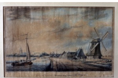
Schagen: Menisweg – Eigenaar onbekend – Restauratie nodig
