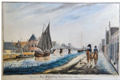
Schagerbrug: van de Noordkant - Zijper Museum – Restauratie nodig
