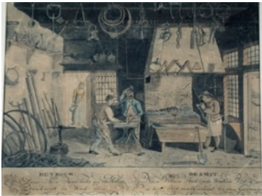
Haringhuizen: Interieur Smederij – Eigenaar bekend Restauratie nodig
