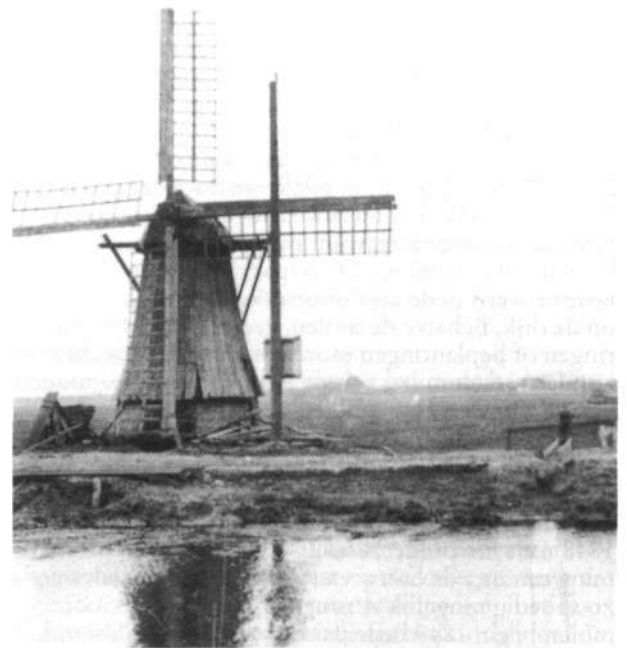
De tweede molen (locatie B) in zijn nadagen. De functie is al overgenomen door de elektrische pomp rechts, die het overtollige water via een houten goot over de kade pompt. (coll. mevr. G. Friks-Bos)
