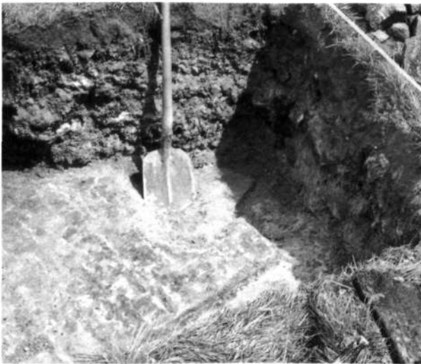
Blootlegging van het fundament van de molen: een penant met de aanzet van de veldmuren. (foto C. Otter)
