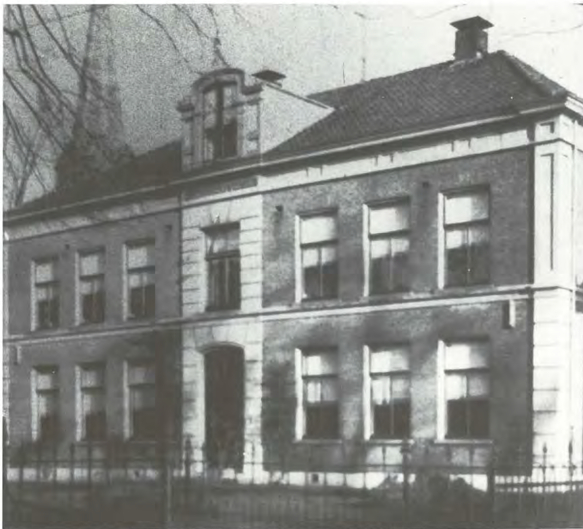
Het weeshuis dat in de vorige eeuw gebouwd werd voor rond f 13.000,—. Het gold als het mooiste, het modernste en rijkste van het land. Nu is supermarkt Konsum er in gevestigd aan de Laan.
