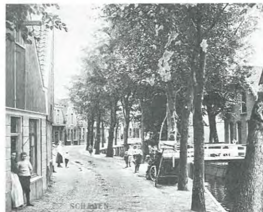
Net voorbij de 'Stenen Pijp' gaan we het Noord op. Hier staat Mevrouw Ploeger nog voor haar slagerswinkeltje, waar nu nog de slagerij is. Rechts, de timmerwerkplaats van Jan Keesman.
