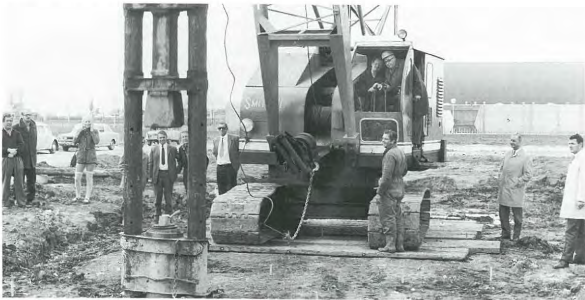
Jaap de Wit en Jan Houtkoper aan de slag aan de Goudkust.
