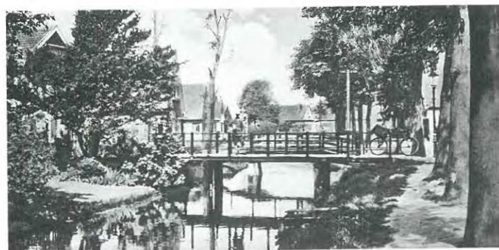
Brug voor het Nespada. En van Chris van Lint aan de overkant.
