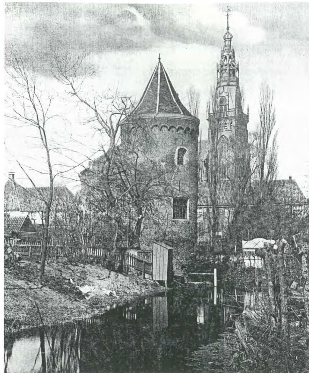
Het voormalig slot te Schagen. Een der overgebleven torens.
