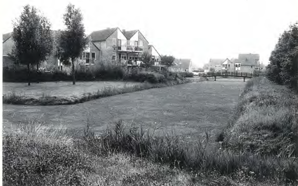
Om het hemelwater goed op te kunnen vangen is voldoende wateroppervlak noodzakelijk. Als aanvulling op een aantal bestaande sloten werden met het oog hierop ook een aantal waterpartijen aangelegd.
