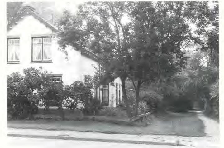
Station De Loet zoals het nog altijd te zien is, met rechts het trampadgedeelte in de wijk Waldervaart.
