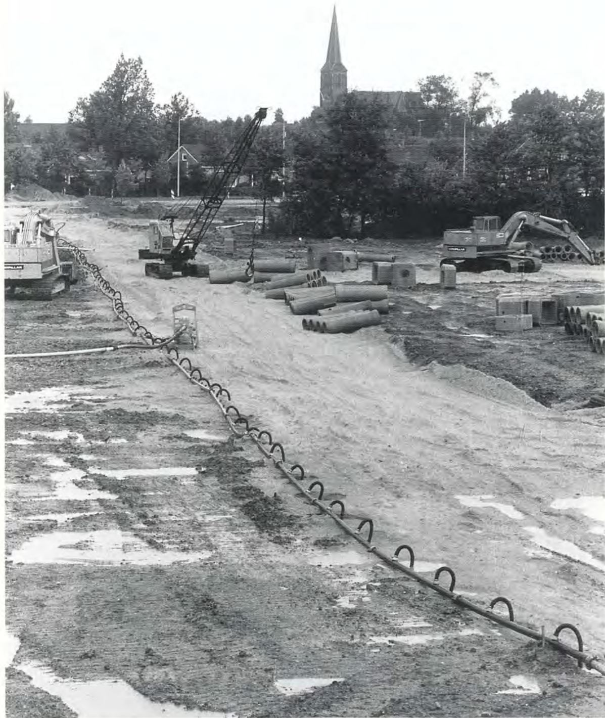
Een van de eerste werkzaamheden in Muggenburg, was het aanleggen van een ontsluitingsweg, de huidige Verzetlaan.
