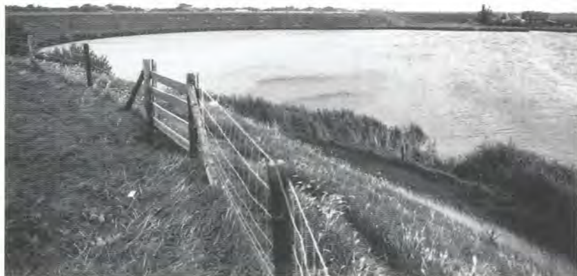
De West-Friese dijk, die vanaf 1250 het oude land van Schagen heeft behoed voor algehele overstroming.
