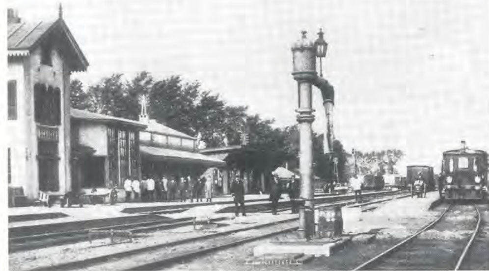
Station Schagen met rechts een tram. De waterkolom op de voorgrond werd gebruikt om de stoomlocomotieven van het zo noodzakelijke water te voorzien.
